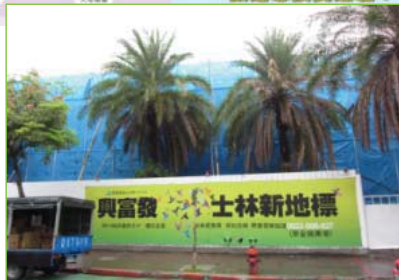
金雞廣場改建 圓山一號院大型商場
